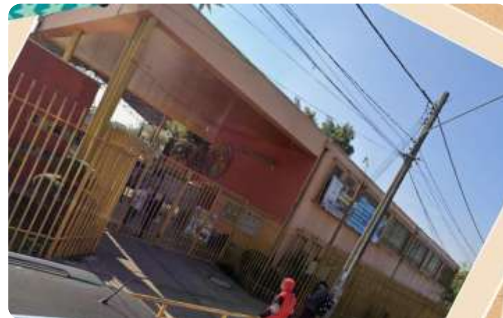
Acceso principal de la Escuela Melvin Jones
