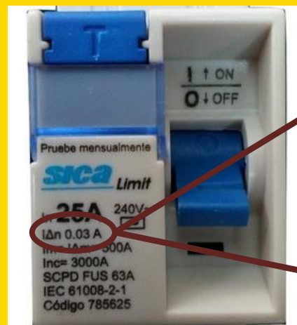
Disyuntor Hogareño Nos salva la vida al detectar fugas de corriente superiores a 0,03 A = 30 mA
